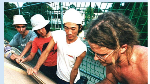
Workcamp 1994: Bauarbeiten an der Pressehütte (Bild: FBS)
